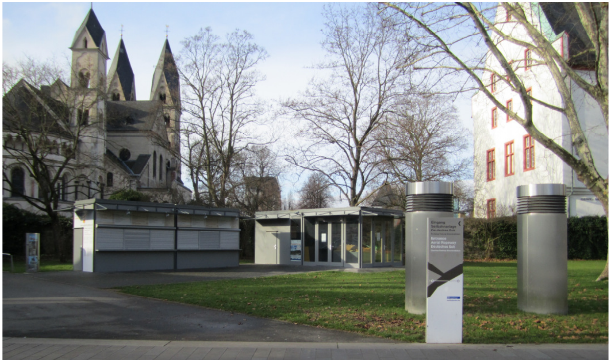
Abb. 8: Bestandssituation Containergebäude im Bereich der Talstation
