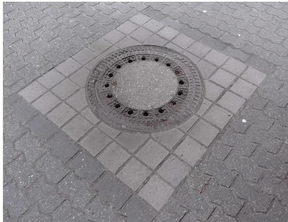
**Bild 12: Formsteine für die Einfassung von Kanaldeckeln**
