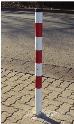
Alternativ setzt die Stadt Koblenz auch **selbstgebaute Absperrpfosten**, mit einer Höhe von 90 cm ein. Diese sind aus alten Schilderstandrohren hergestellt. Sie werden weiß lackiert, mit roter Reflektionsfolie beklebt und erhalten einer Kappe. Die selbstgemachten Pfosten werden in Schilderhülsen gesetzt (siehe 4.1.1.).
