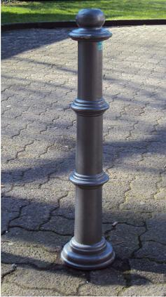
Im Altstadtbereich wird häufig ein 90 cm hoher, dunkelgrauer Poller (Altstadtpoller) mit umgossenem Stahlrohrkern aufgestellt. Er wird mittels Adapter in die gleiche Bodenhülse gesetzt, wie der Standardpoller. Auch dieser Absperrpfosten wird herausnehmbar eingebaut und mit einem Dreikantschloss verriegelt.
