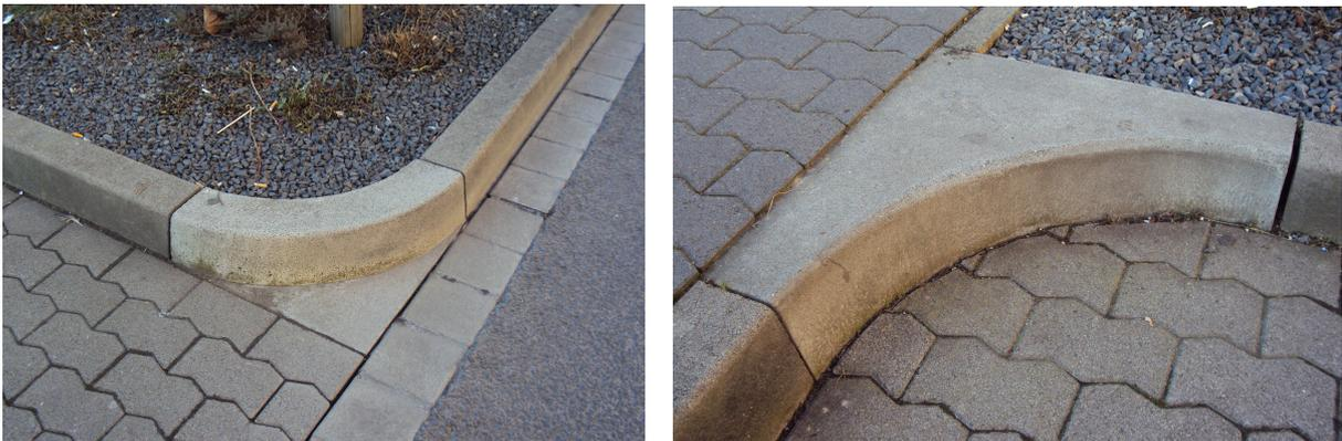
**Bild 44: Beispiel für Fertigteil-Lösungen für 90° Ecken mit Hochborden**
