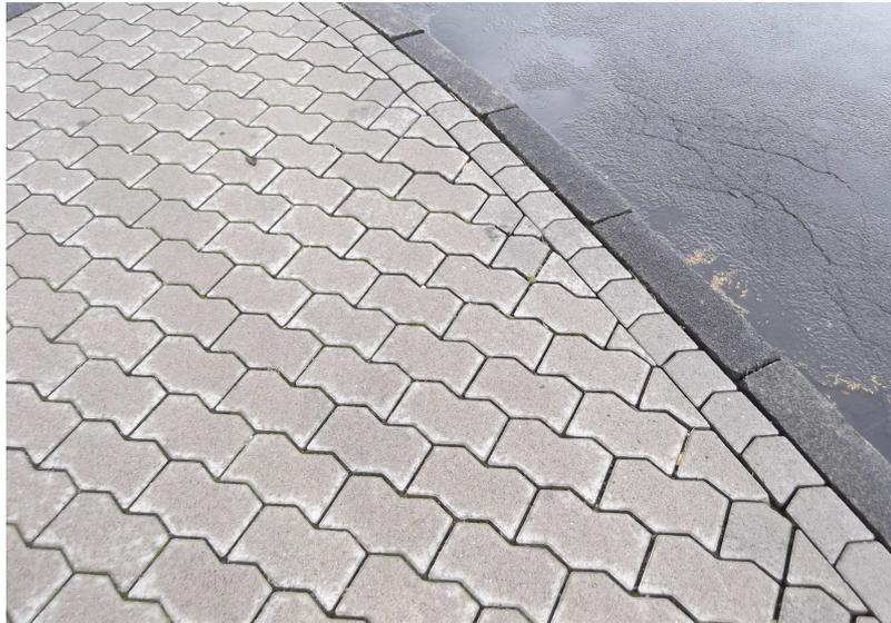
**Bild 5: Läuferreihe im Radienbereich**
