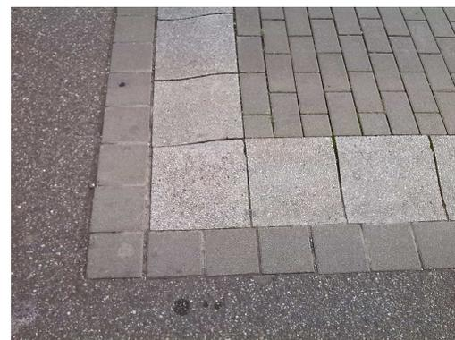
**Bild 28: Aufpflasterungen (Läufer innen fehlt)**
