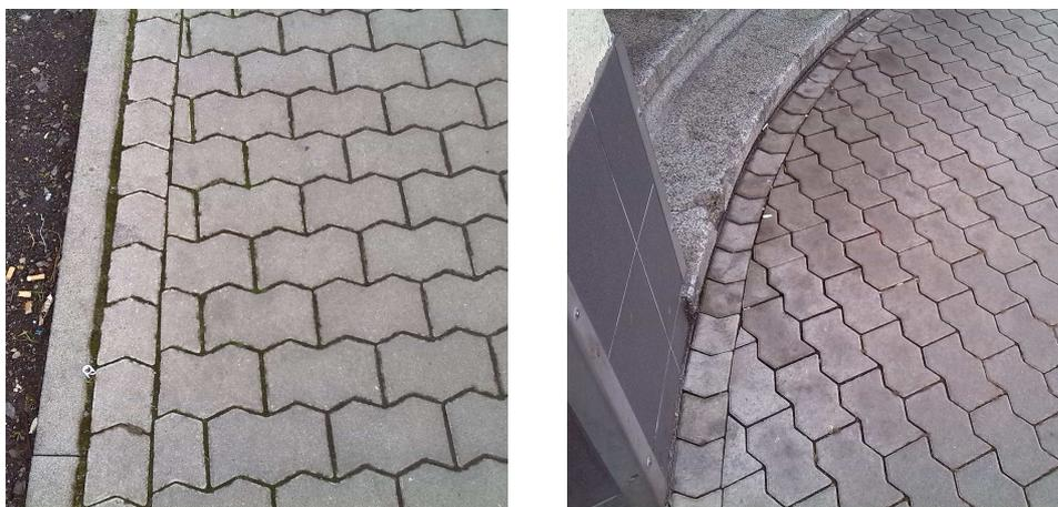
**Bild 6: Zweckmäßige Läuferreihe am Rand aus halben Steinen**
