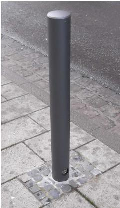
Auf und im Umfeld des ehemaligen BUGA-Geländes wird der sogenannte BUGA-Poller eingesetzt. Hierbei handelt es sich, wegen der Systemgleichheit, um den **Absperrpfosten „Sentinel“** der Firma „ABES Public Design“, in Stahl mit 3p-Technologie, lackiert nach DB 703 Eisenglimmer.
