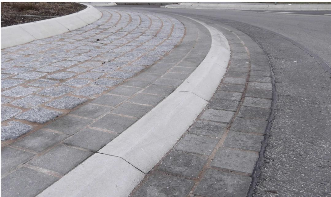
**Bild 36: Innenrand der Fahrbahn (Foto)**
