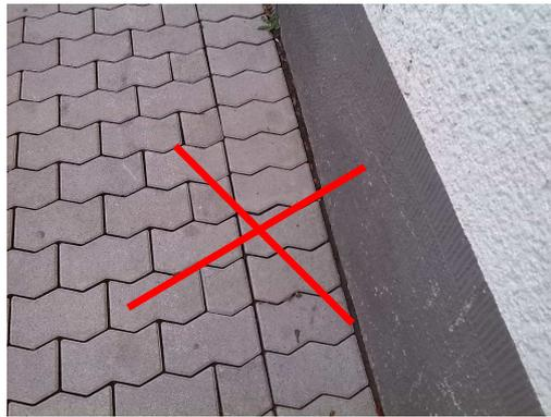
**Bild 7: Falsch - Läuferreihe am Rand aus ganzen Steinen**
