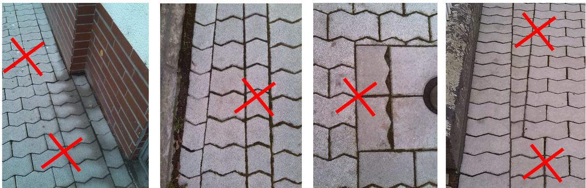
**Bild 8: Nicht gewollte parallele Schnitffugen**
