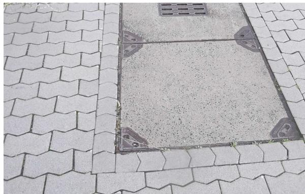
**Bild 13: Schachtdeckel mit Läuferreihe eingefasst**
