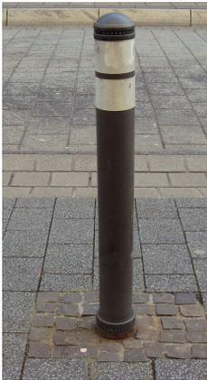
Zum Teil werden im Stadtgebiet auch **flexible Poller**, mit einer Höhe von 80 cm, eingesetzt. Das äußere, anthrazit farbene Rohr, ist mit Ringen aus retroreflektierender Folie versehen. Der Poller wird mittels Adapter ebenfalls in Bodenhülsen gesetzt.
