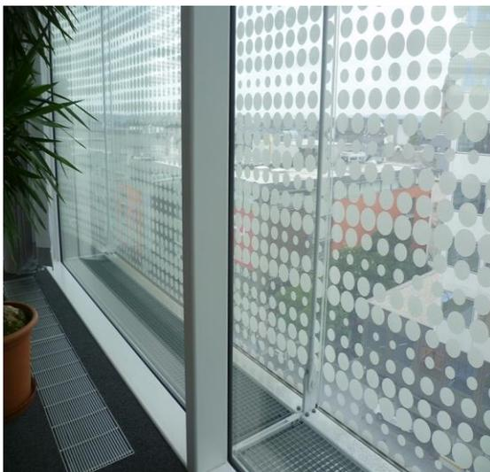
Abb. 18 Innenansicht, Detail zweischalige Fassade.
