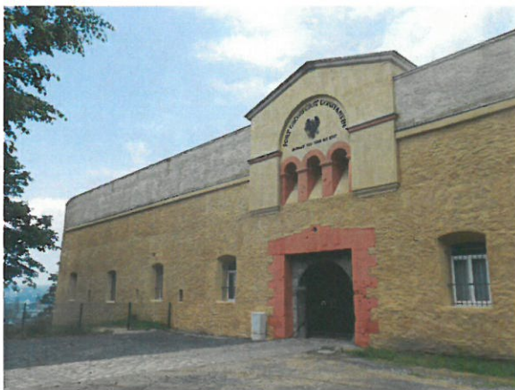
Westseite des Schutzbunkers im Nordflügel des Forts Konstantin in Koblenz-Karthause
