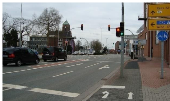
Abbildung 50: Radfahrschleuse am Knotenpunkt
