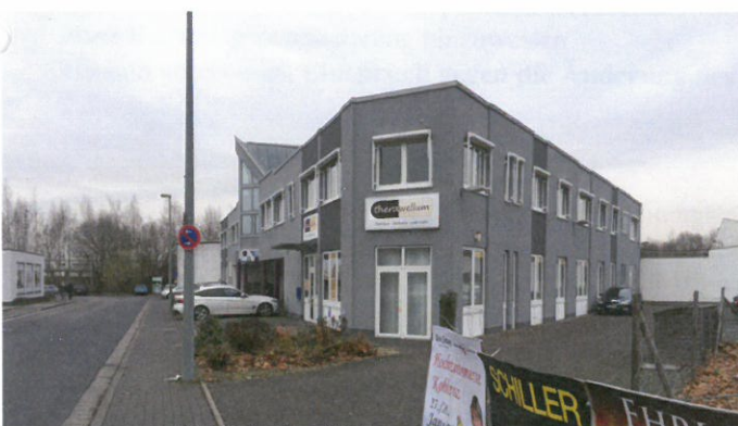
Bild 3: Die gesamte Gebäudebreite wird als Zufahrt genutzt. Als Rangierfläche wird die Straße genutzt. Wenig Bepflanzung. Keine Grünfläche. Mülleimer im Eingangsbereich zum Nachbar.
