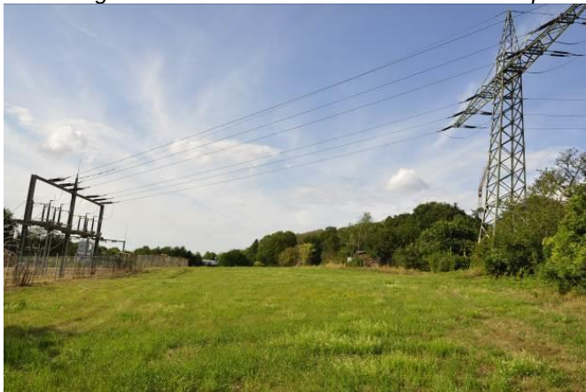
Abbildung 25: Grünlandfläche nahe dem Umspannwerk
