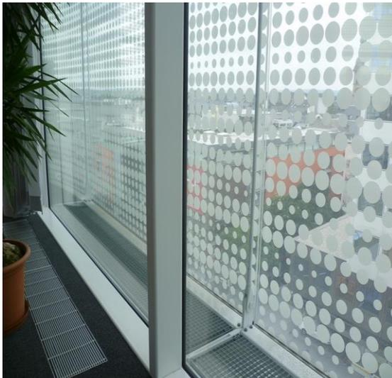
Abb. 18 Innenansicht, Detail zweischalige Fassade.
