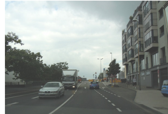
Beispiel Schutzstreifen auf der Straße An der Moselbrücke (Foto: LK Argus)
