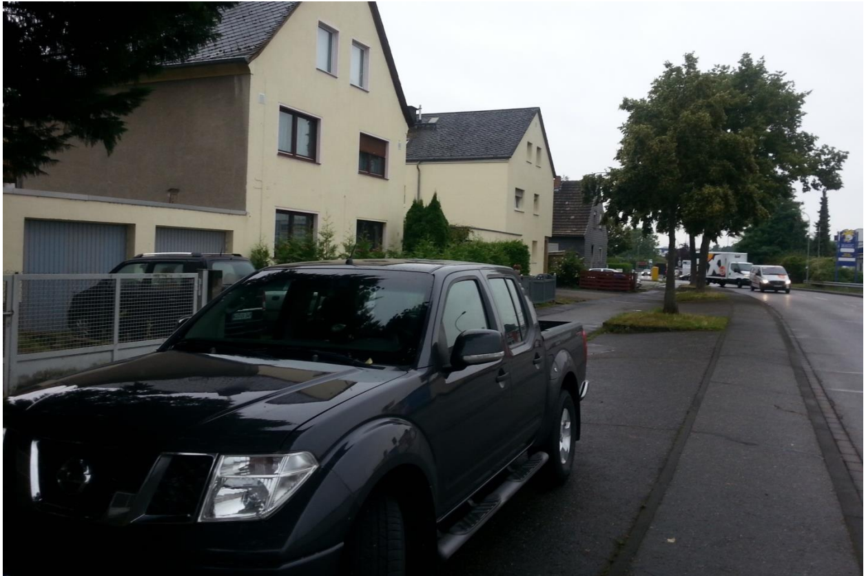
Bild 2: Bauliche Trennung des Fußweges „In der Wehring“, hier vor den Häusern Nr. 3 (vorne links) bis Nr. 1 (hinten), zur Friedrich-Mohr-Straße mit Zufahrtssituation
