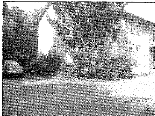
Bild 4 Zufahrt Parkplatz und Zugang Gebäude
