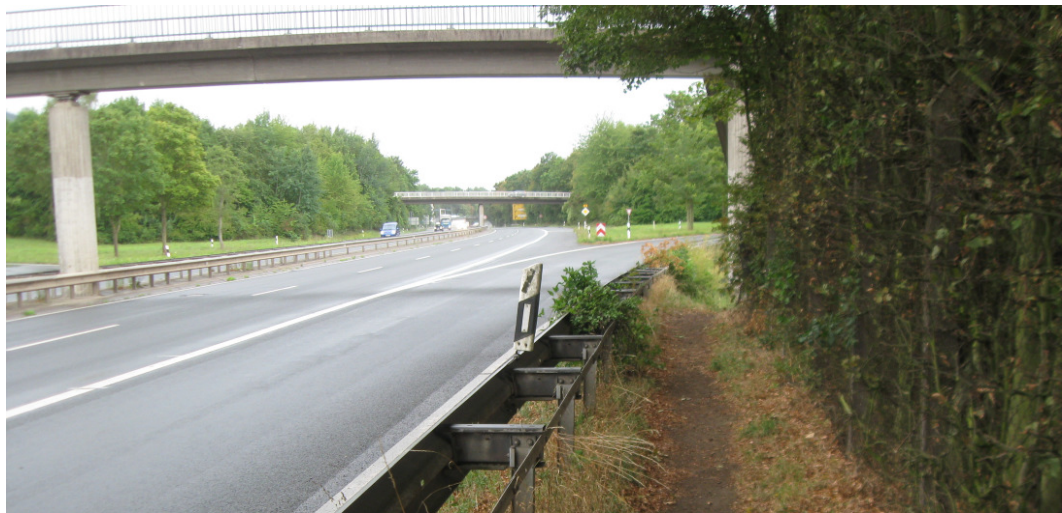
Abb. 4 Fußpfad entlang der B 42 mit Fußgängerbrücke im Hintergrund
