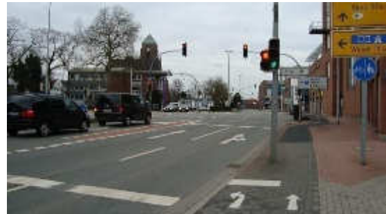
Abbildung 50: Radfahrschleuse am Knotenpunkt
