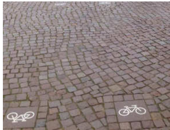
Abbildung 42: Leitelemente für Radfahrer in Fußgängerbereichen
