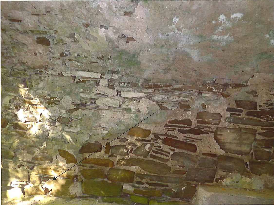
Bild 4 ausgespülte Vermörtelung
