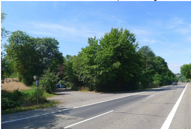
Abbildung 7: Blick in Richtung des Lagerplatzes/ Bauhofs mit randlichem Gehölzbestand von der Landesstraße 127 (Blickrichtung Nordosten → Südwesten)
