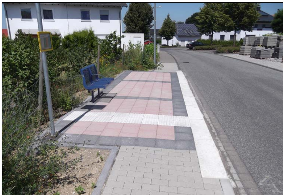
Abbildung 9: Beispiel barrierefreier Aus-/Neubau bzgl. Haltestellen-Wartefläche
