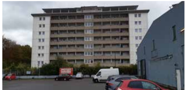
Abbildung 23: Solitärgebäude an der Theo-Mackeben-Straße
