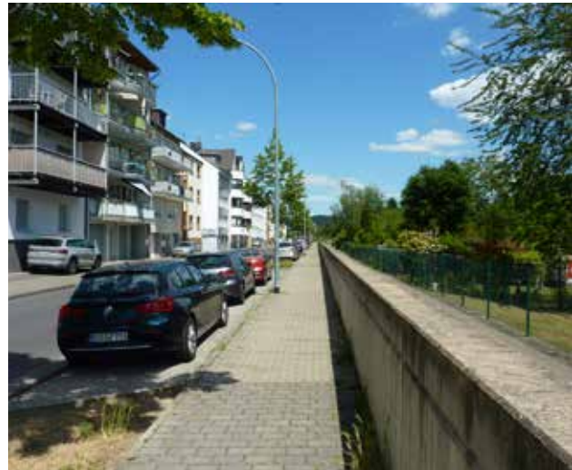
Abbildung 85: Die Hochwasserschutzmauer zwischen dem Grabeland und der Neuendorfer Straße.
