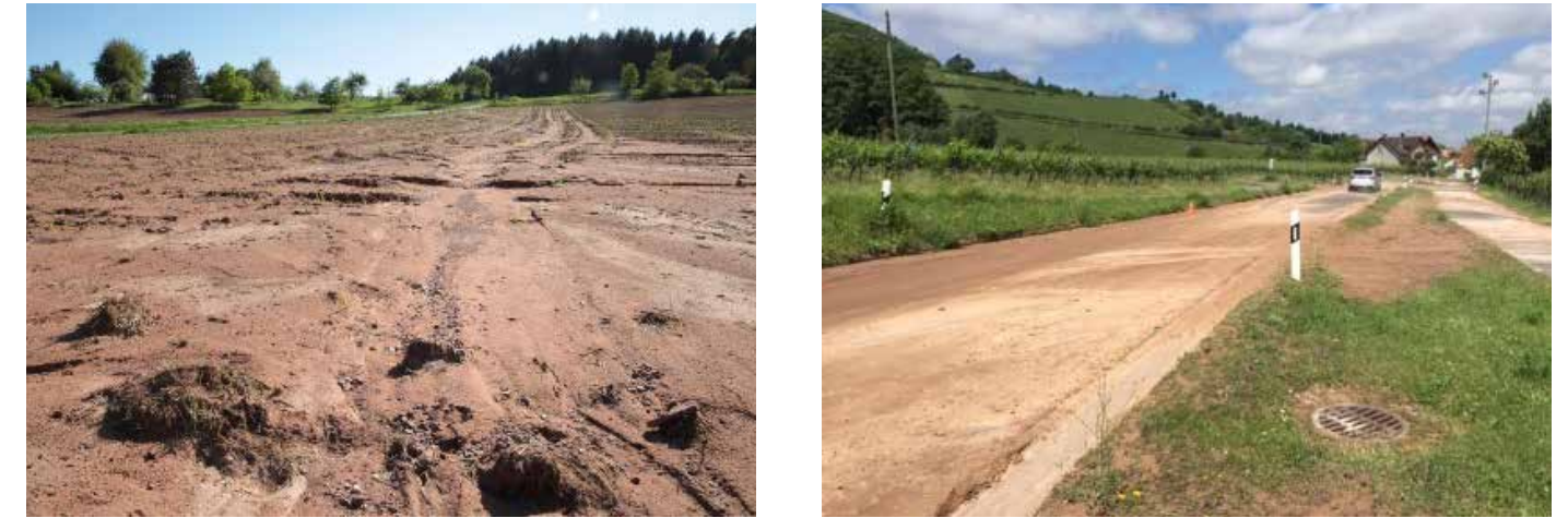
Abb. 20: Bodenerosion (links, Foto: Segatz) und Ablagerungen des abgeschwemmten Bodens auf Verkehrsstraße (rechts, Foto: Kotremba)
