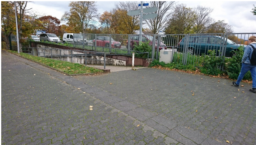
Abbildung 41 – Schüler nutzen die Querungshilfen, hier die Unterführung, um zu den Schulbussen auf der anderen Seite der Simmerner Straße zu kommen.
