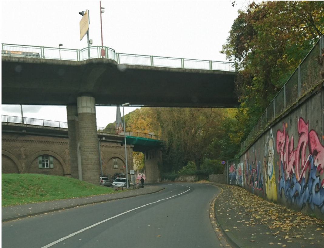
Abbildung 52 – Blick auf die Brückenquerungen über der Emser Straße
