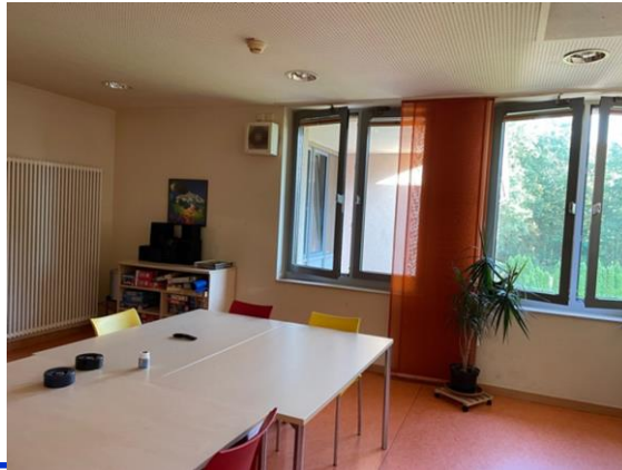
Fensterlüftungssystem mit einfachem Abluftventilator
