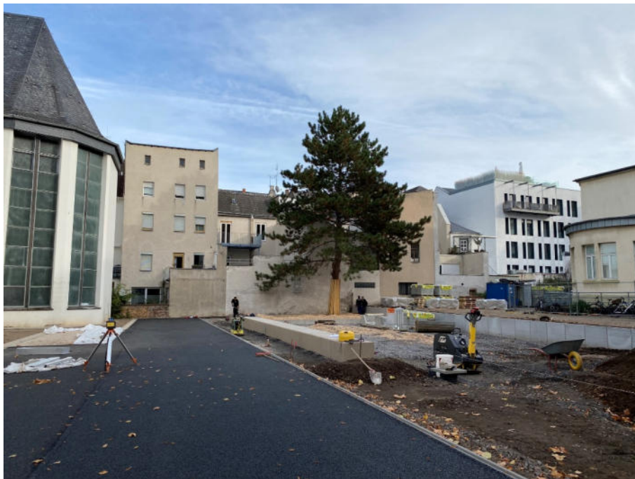
Abbildung 2 Setzen der Blockstufen
