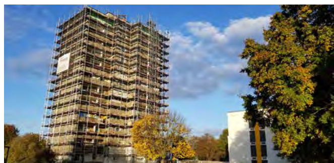
Gebäude in der Sanierung
