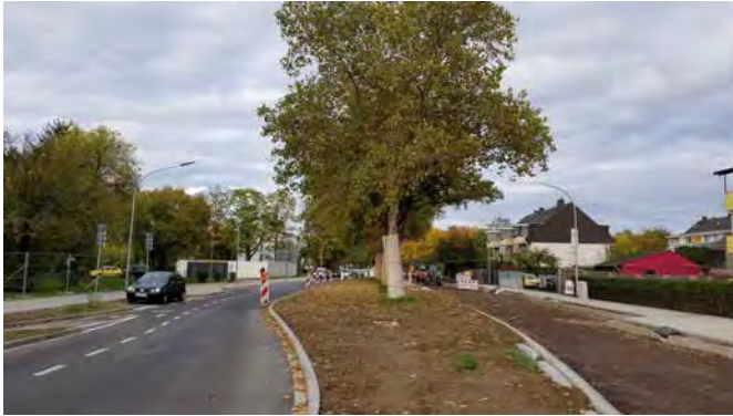
Wallersheimer Weg im Umbau
