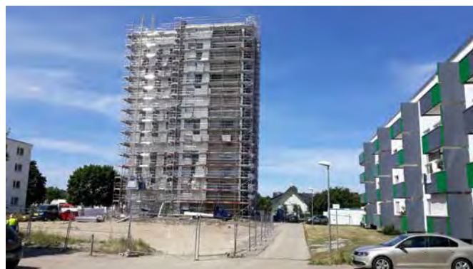
Fritz-Michel-Straße 25, in Sanierung
