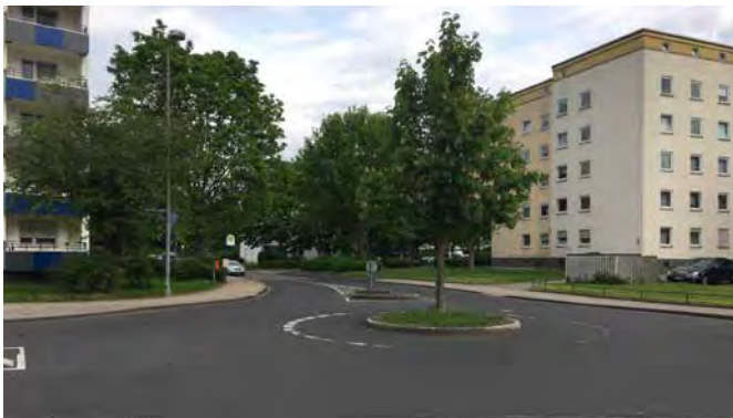
Ausbau Fritz-Michel- und Fritz-Zimmer-Straße
