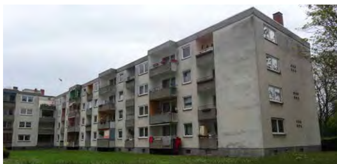
Gebäudekomplex vor der Sanierung
