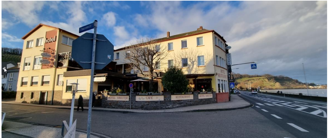
Abb. 3 Entréesituation Stauseestraße / Moselweinstraße mit Hotelbestand und Terrasse
