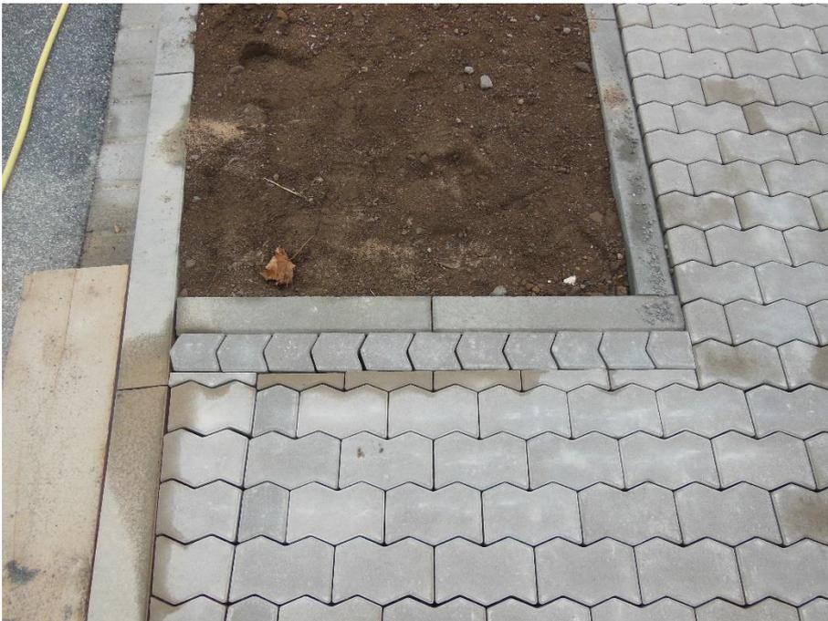
**Bild 6: Beispiel zur Verlegung einer Läuferreihe**
