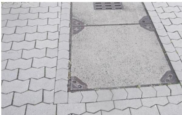
**Bild 13: Schachtdeckel mit Läuferreihe eingefasst**
