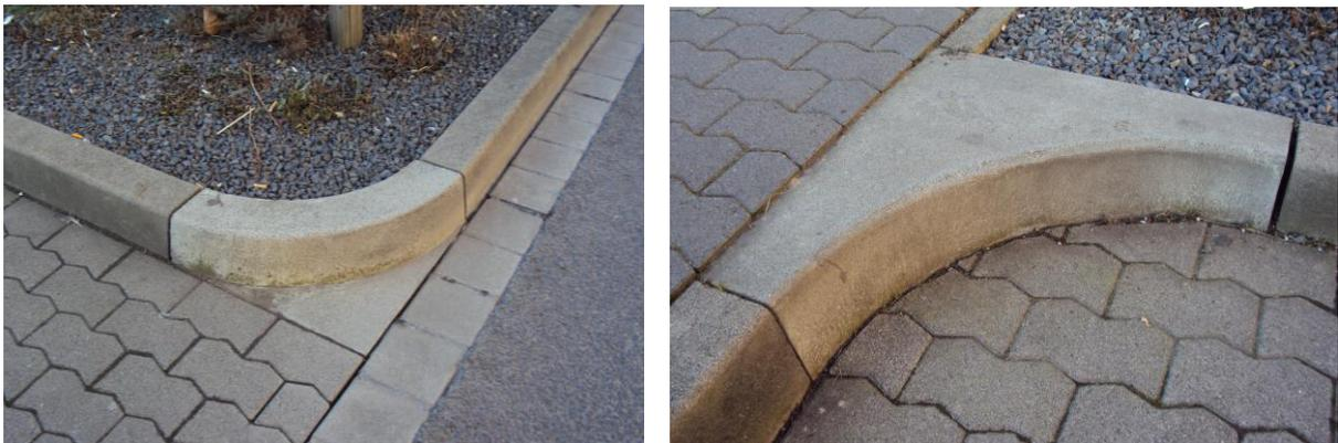
Bild 40: Beispiel für Fertigteil-Lösungen für 90° Ecken mit Hochborden
