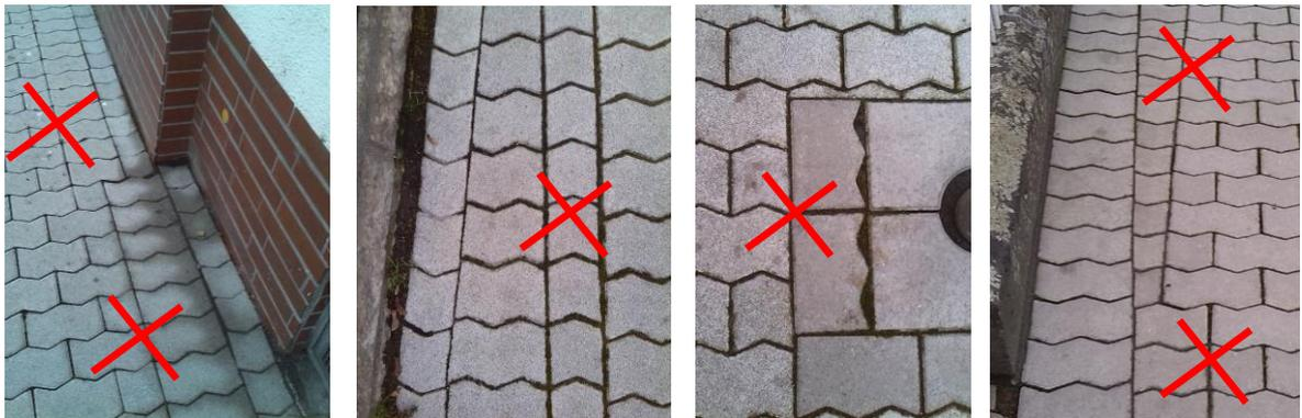
**Bild 7: Nicht gewollte parallele Schnittfugen**
