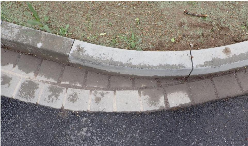
Bild 44: Rinne, Wechsel von zwei- auf einzeilig
