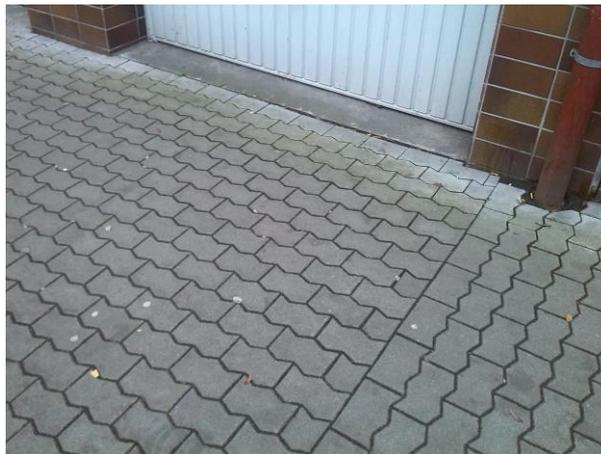
**Bild 9: Gedrehtes Pflaster in einer Zufahrt**
