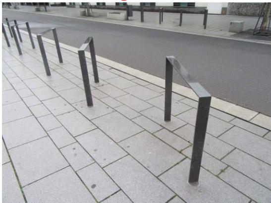
Fahrradanlehnbügel aus Stahl, bestehend aus zwei senkrechten Pfosten und einem horizontalen Holm, Ecken rechtwinklig verschweißt; ortsfest zum Einbetonieren; Höhe über GOK 800 mm, Tiefe unter GOK ca. 400 mm, Breite 800 mm; aus **Flachstahl** 80 mm x10 mm, verzinkt und farbbeschichtet mit 2K - Epoxydharzlack, **Farbton DB 703**
