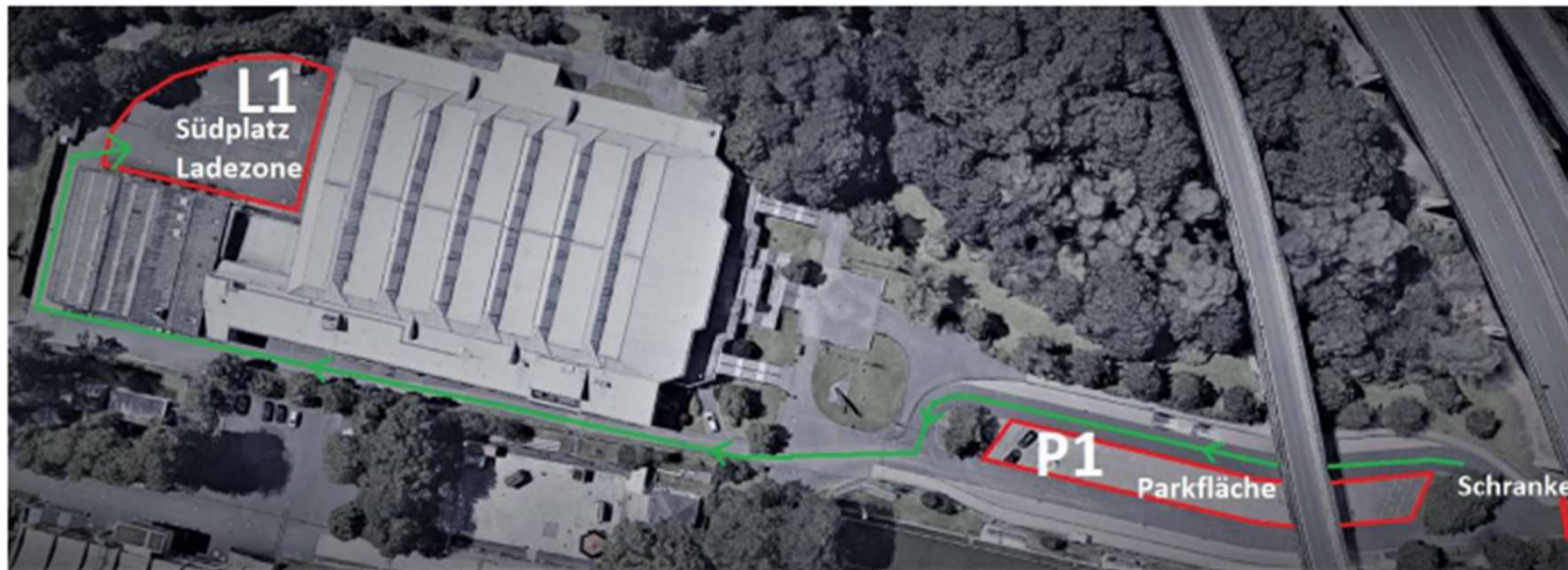
Grundstück der CGM Arena
