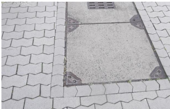
Bild 13: Schachtdeckel mit Läuferreihe eingefasst
