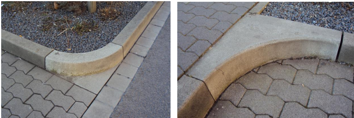
Bild 40: Beispiel für Fertigteil-Lösungen für 90° Ecken mit Hochborden
