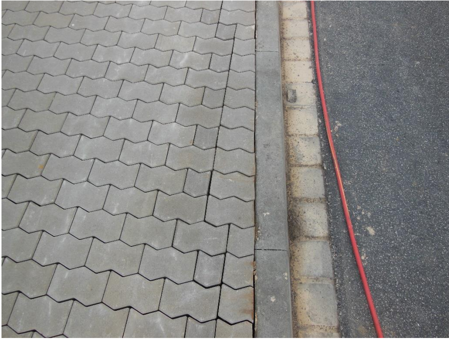
Bild 4: Positivbeispiel zur Pflasterverlegung
