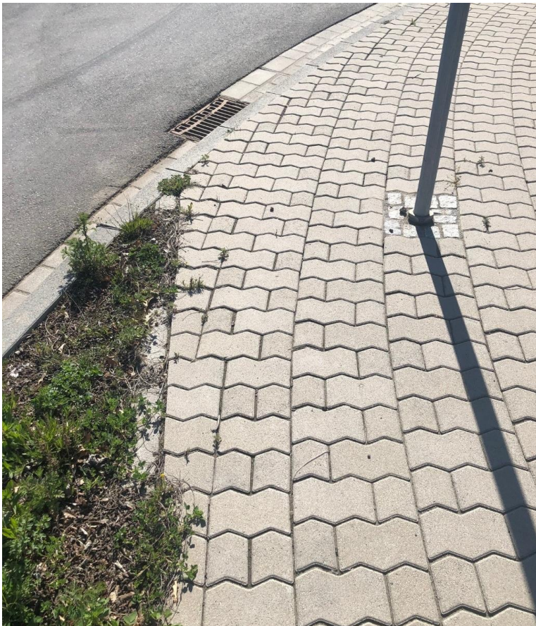
Bild 5: Positivbeispiel zur Pflasterverlegung
