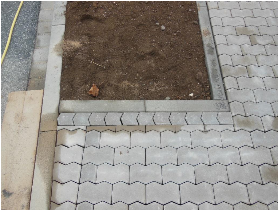
Bild 6: Beispiel zur Verlegung einer Läuferreihe
