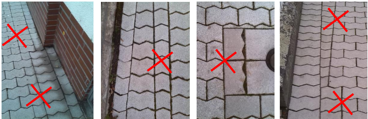
Bild 7: Nicht gewollte parallele Schnittfugen
