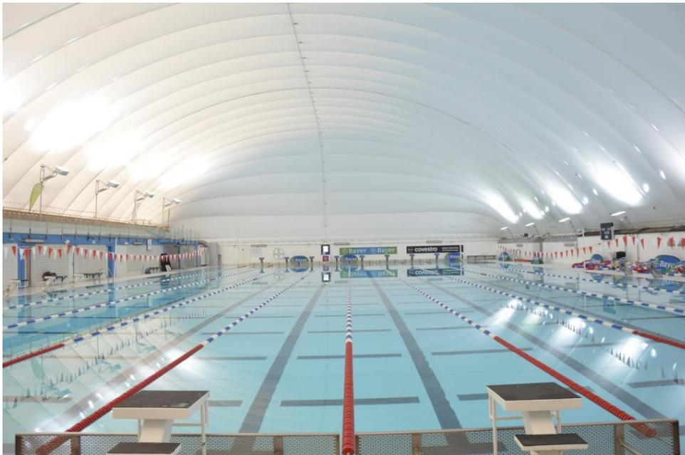
Abbildung 22 – Beispiel Traglufthalle über Schwimmbad (Quelle: Kompendium Schwimmbad)
