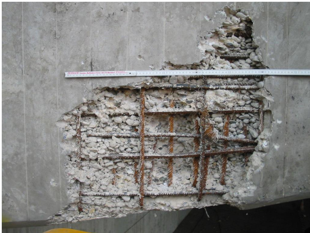
Abb. 6 freiliegende Bewehrung (Kiesnest) Europabrücke stadtauswärts
