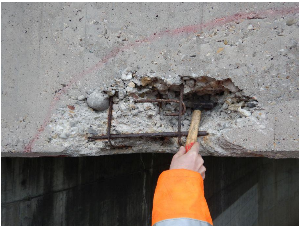
Abb. 2 Betonausbruchstellen Europabrücke stadteinwärts
