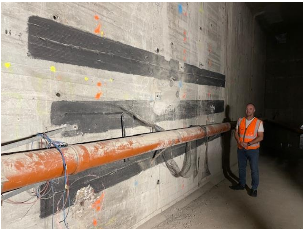
Abb. 4 gescheiterter Sanierungsversuch im Stegbereich Europabrücke stadteinwärts (Elektroosmose)
