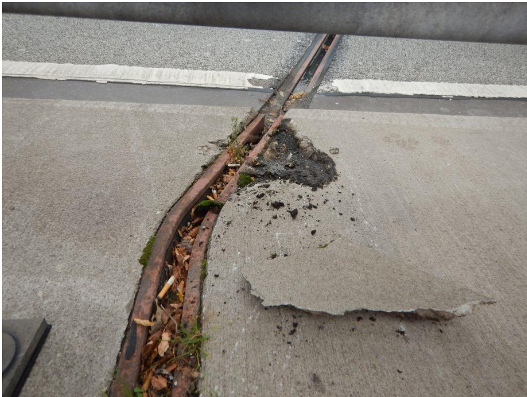
Abb. 3 schadhafte Dehnfuge Europabrücke stadteinwärts
