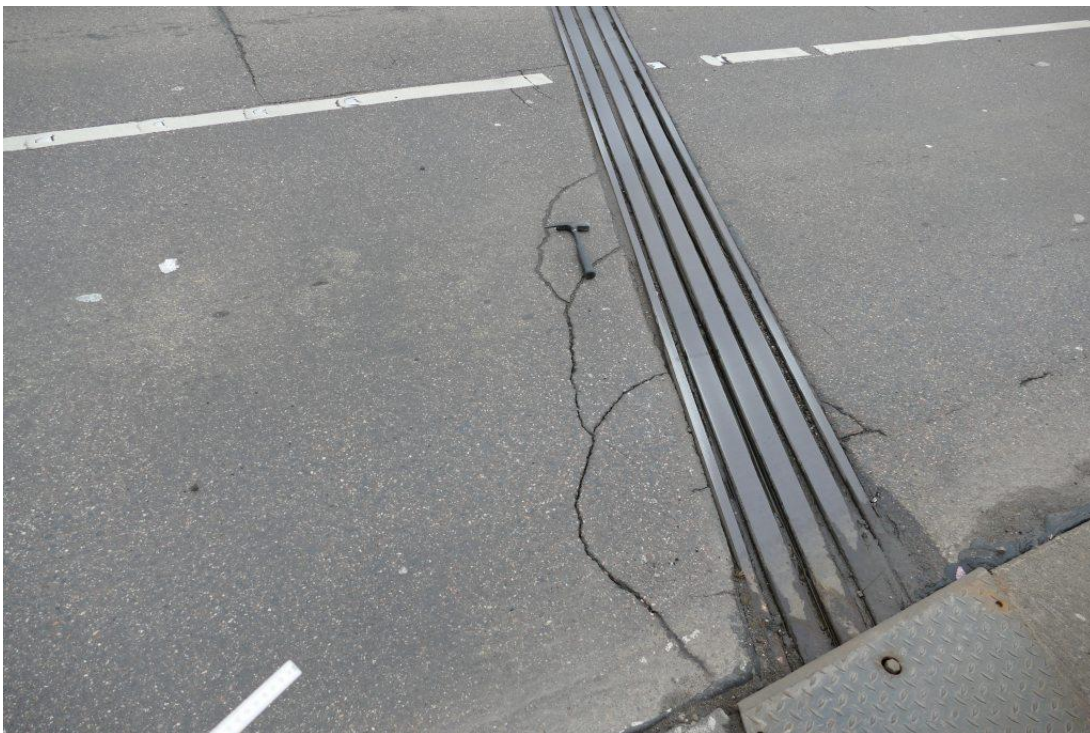
Abb. 8 schadhafte Übergangskonstruktion Europabrücke stadtauswärts
