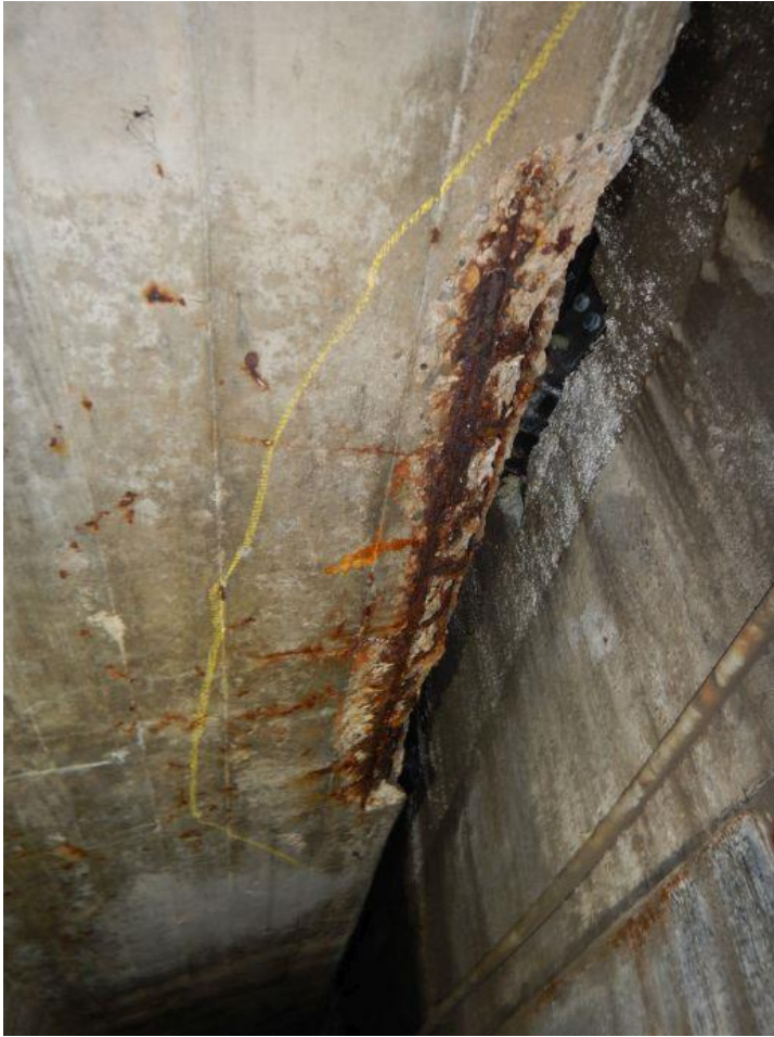
Abb. 7 Korrosionsschäden am Endquerträger Europabrücke stadtauswärts
