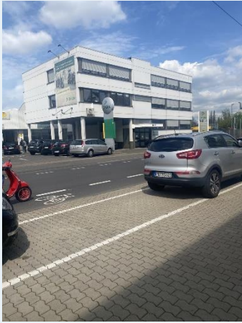
Abbildung 2-34: unübersichtliche Radverkehrsführung durch beidseitige Einbettung von Parkplätzen und Straße
