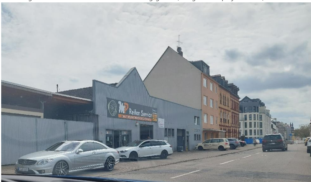
Abbildung 2-13: Ungeordnetes Parken und fehlende Beschattung
