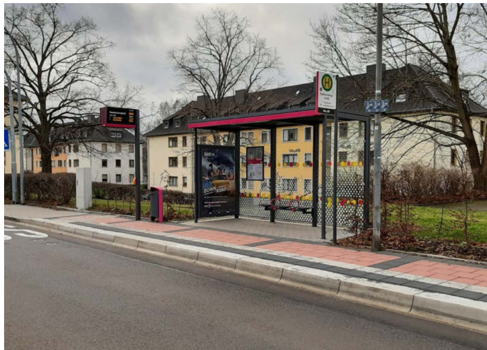
Abbildung 15: Beispiel barrierefreier Haltestellen-Ausbau in Koblenz
