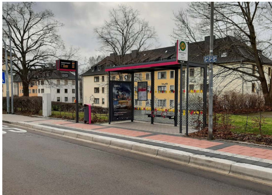
Abbildung 15: Beispiel barrierefreier Haltestellen-Ausbau in Koblenz
