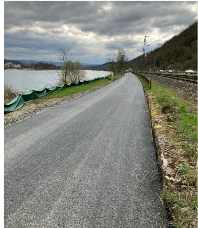
P0779100 | 01.04.25, 12:43 Rhenser Straße 2 164 ° SE
