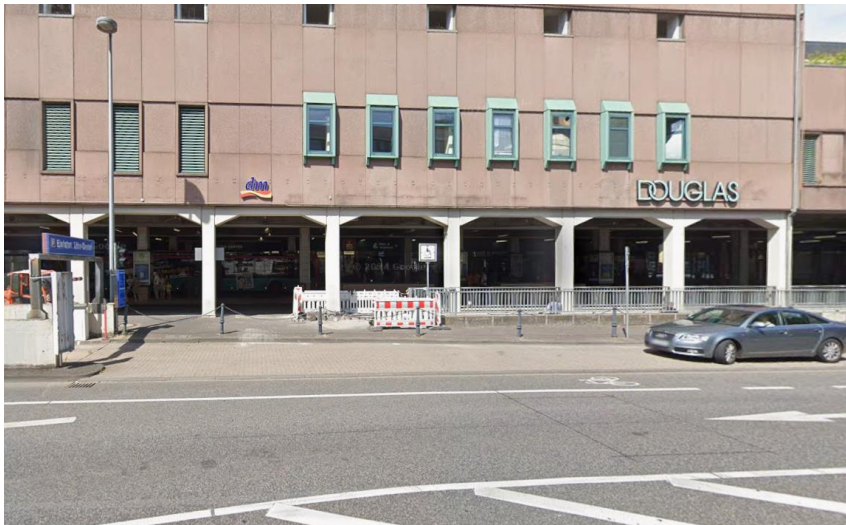
Verbindungsbauwerk West – Löhr-Center
