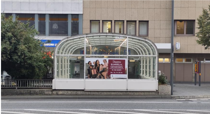
Verbindungsbauwerk Ost – Fischelpassage
