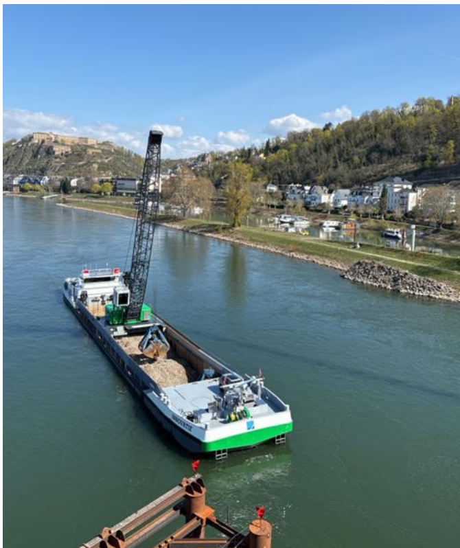
Bild 2 Baggerarbeiten im Rhein
