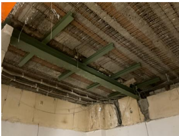
Bilder nach Demontage der abgehangten Decke
