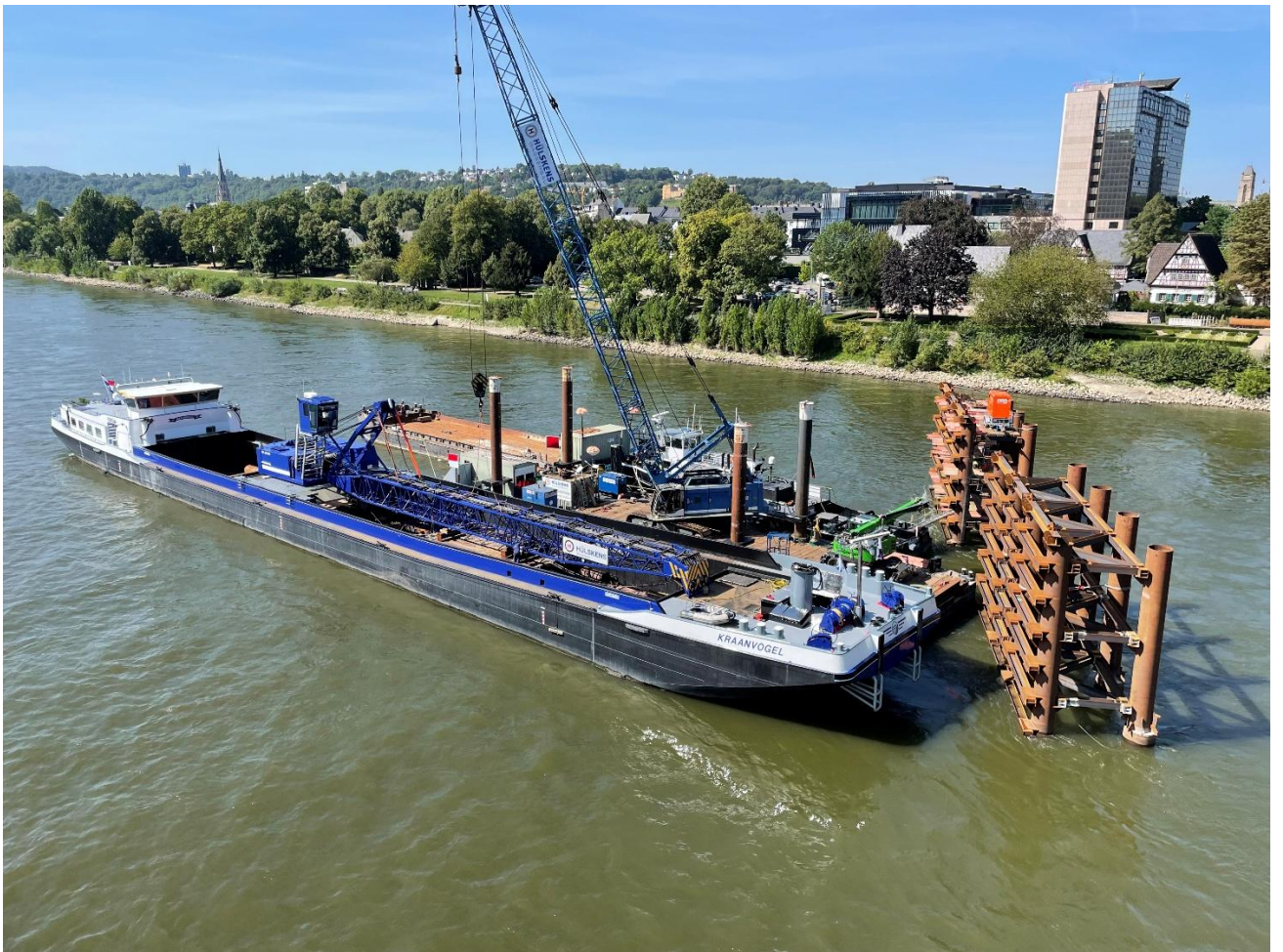
Bild 7 Herstellung der Schiffsabweiser
