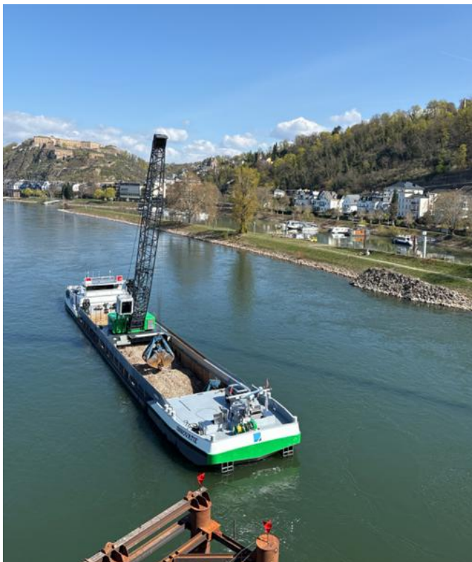
Bild 2 Baggerarbeiten im Rhein
