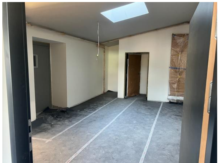
Flurübergang mit neuem Zugang zum Lastenfahrstuhl
