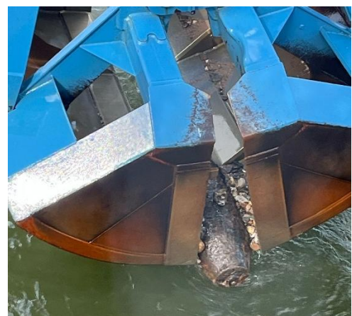
Bilder 3 und 4 Bombenfunde bei Nassbaggerarbeiten
