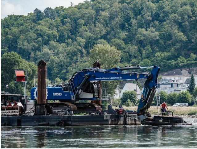
Bilder 5 und 6 Kampfmittelsondierung mit Tauchturm
