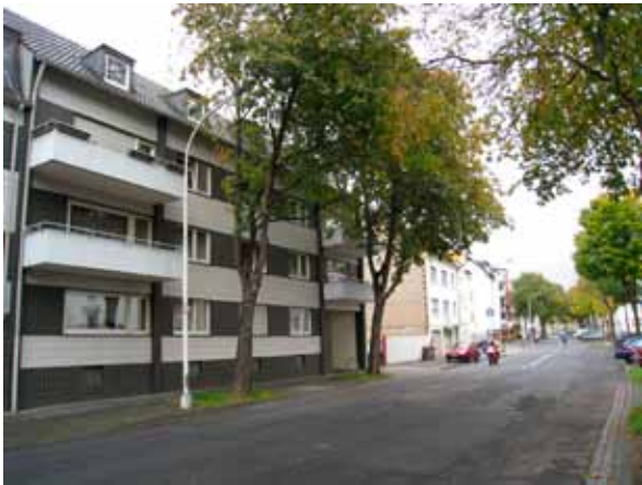
Baumpflanzung zu nah an Gebäuden
