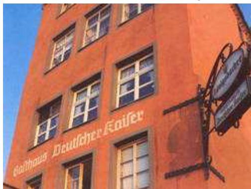
Abb. 2: Deutscher Kaiser vor der Sanierung 6
