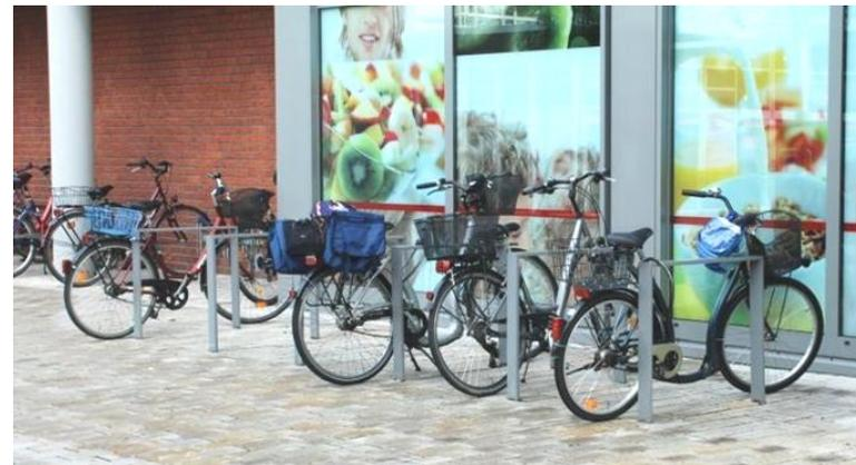
Anlehnbügel für Fahrräder – Flachstahlbügel, feuerverzinkt, farbbeschichtet DB 703 (anthrazit) (z.B. Fa. Thieme GmbH), analog Planung BUGA
